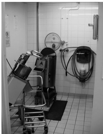
写真－5 野菜下処理室の室内清掃用壁掛け式器具
